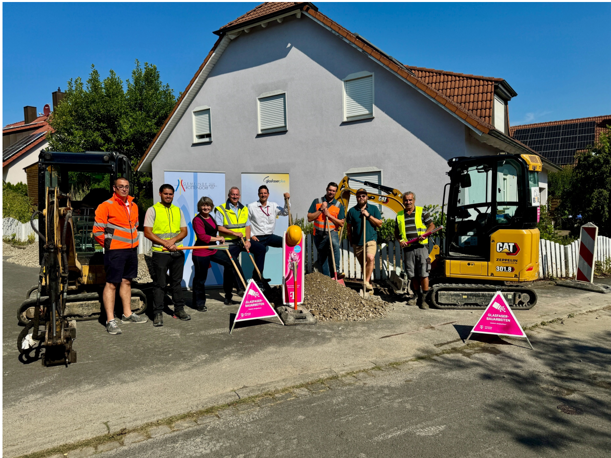
Foto vom Spatenstich in Rottendorf Bildunterschrift Bildrechte Telekom Fotograf: Pascal Seitz
