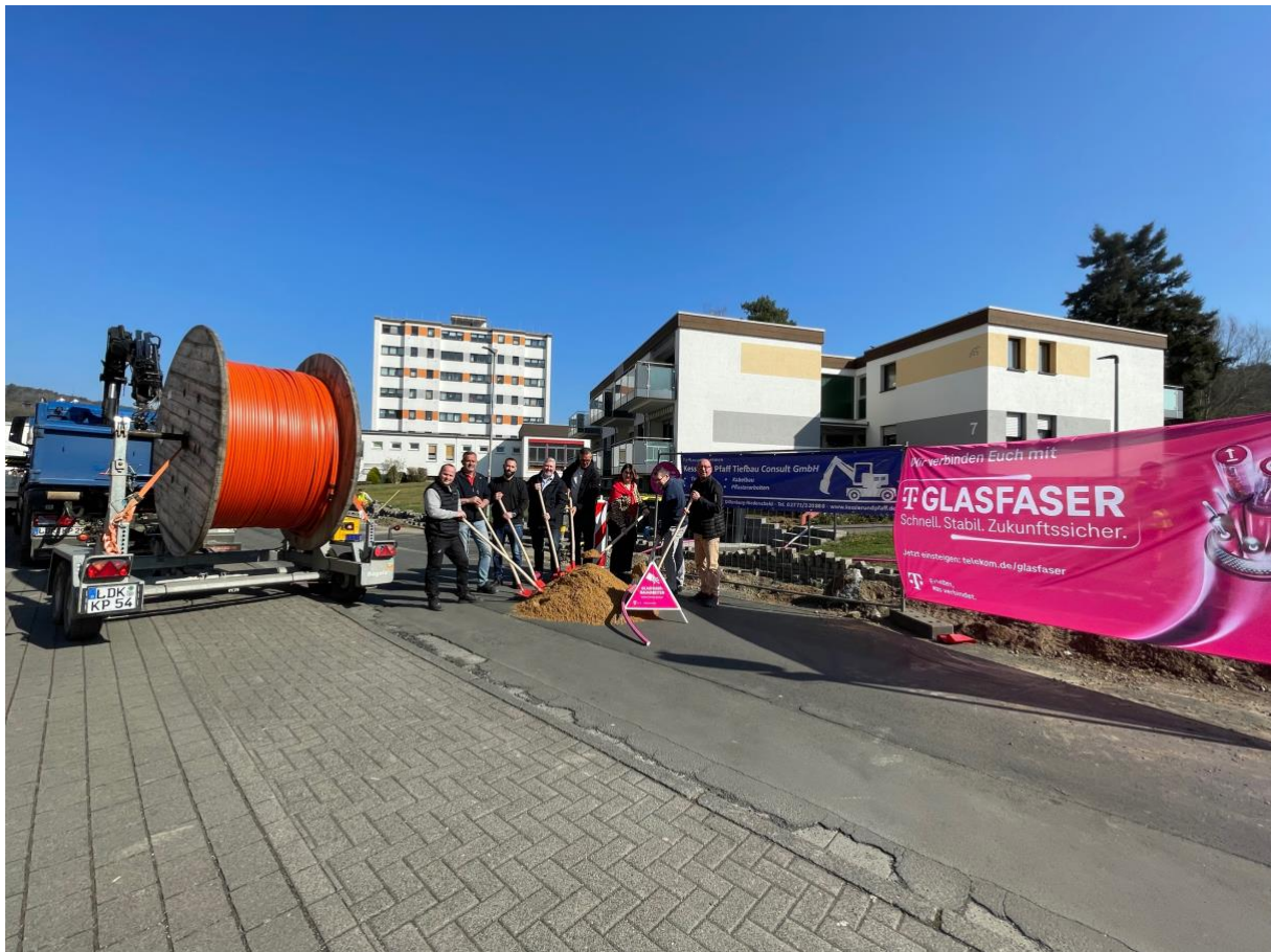
Bildunterschrift Spatenstich Glasfaserausbau Herborn:
