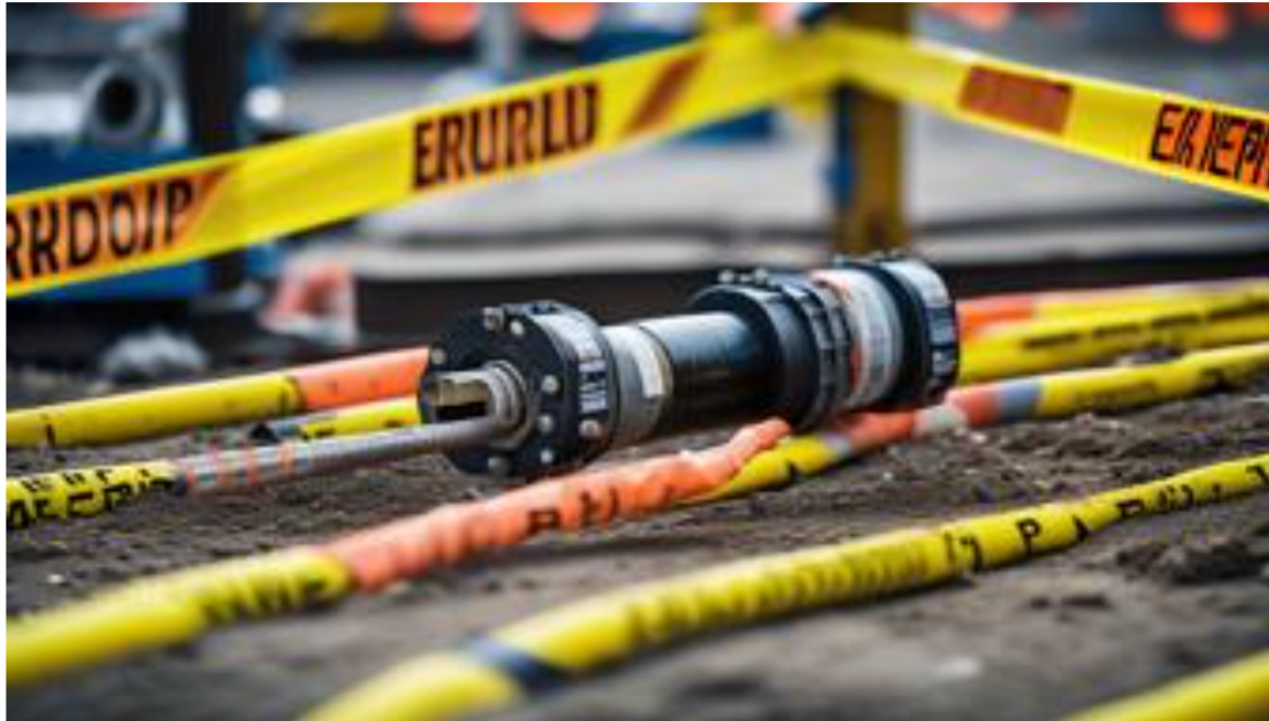
Glasfaserarbeiten gefährden Gasleitungen: Explosion in Daaden gibt Anlass zur Sorge | © Rheinland-Pfalz Kurier
