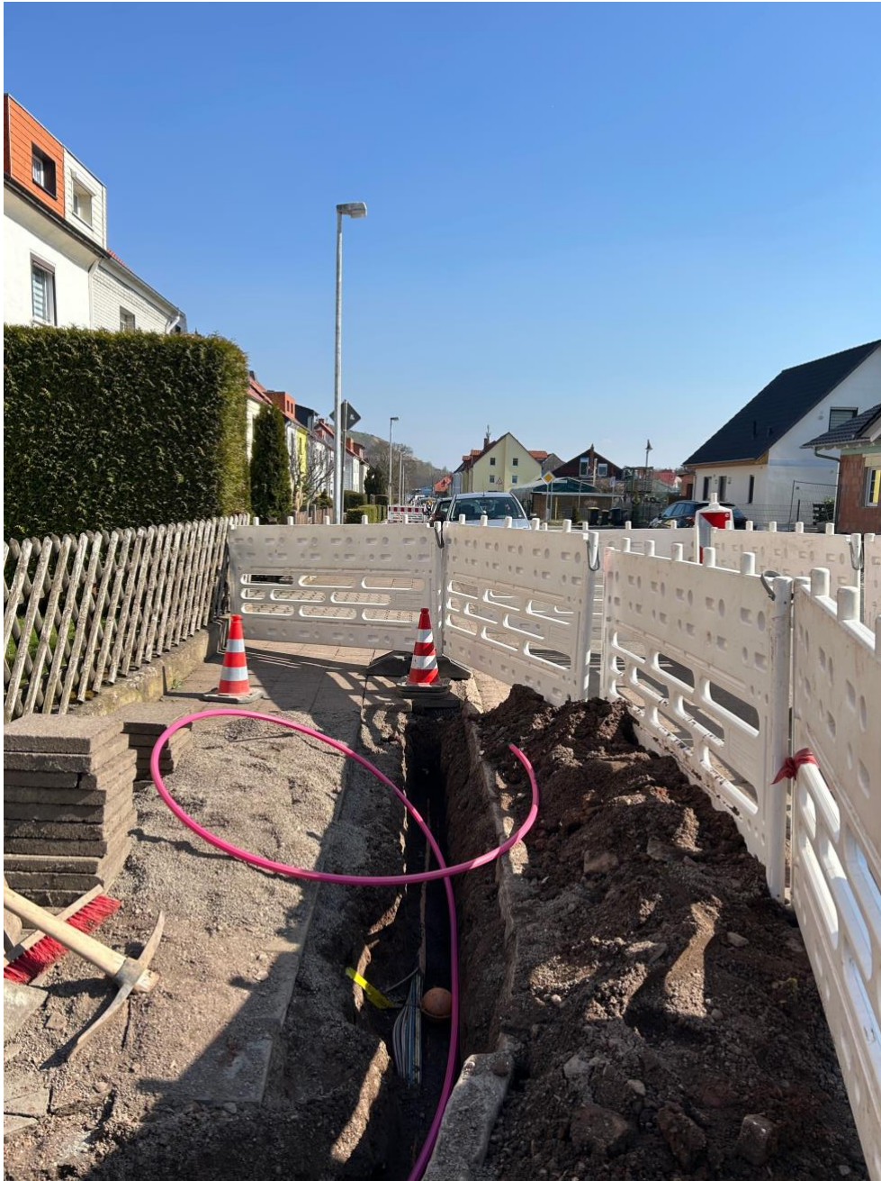
Baustelle Johann-Sebastian-Bach Str.
