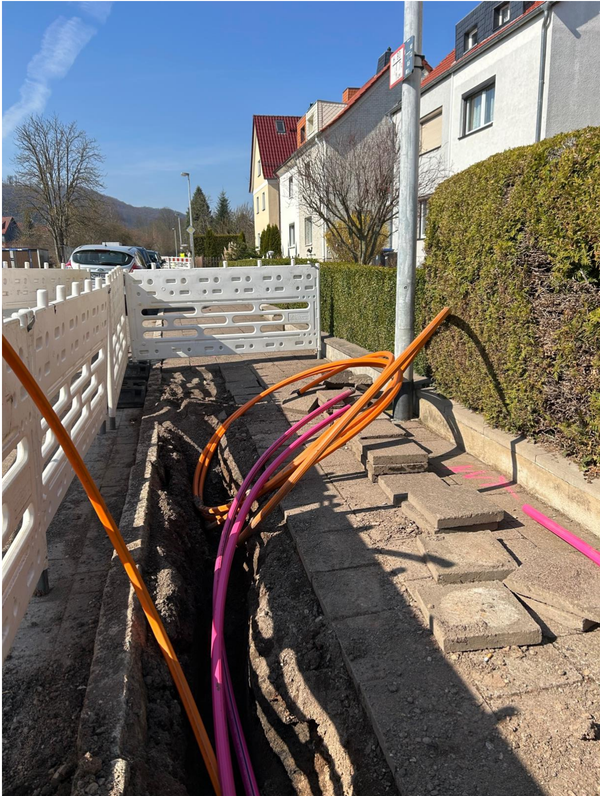
Baustelle Johann-Sebastian-Bach Str.
