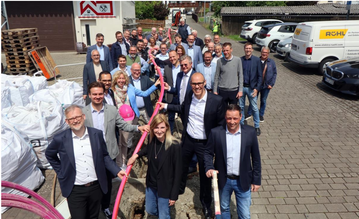
Bildunterschrift Glasfaserausbau Marburg-Biedenkopf:
